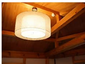
内部から見える構造躯体
