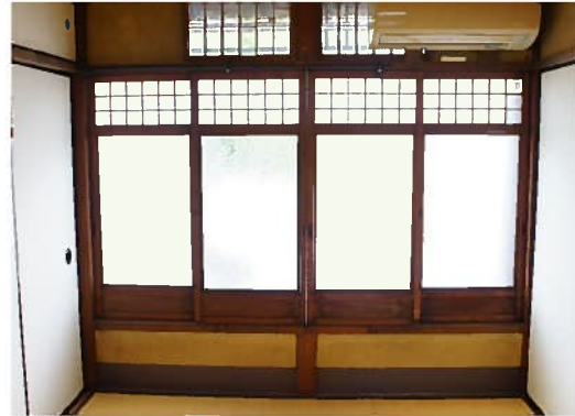
江戸間<柱割り（芯々制）> 柱間隔を固定して畳のサイズを調整
