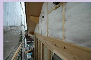
土壁に断熱材を入れた例
