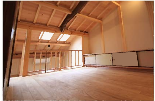
真壁造りのため、木の柱や梁が内部空間に現れており、木の温もりを感じることができます
