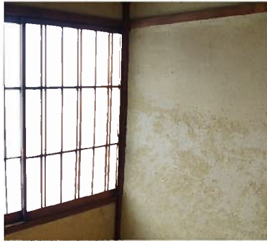
土壁や珪藻土、漆喰などの塗り壁は、調湿効果があるため、室内の湿度を快適に保ちます
