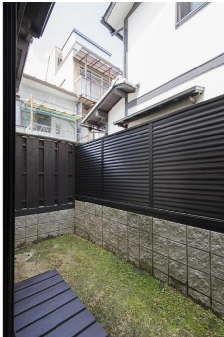
また、路地側と道路側に庇を設け、宅内への直射日光を和らげます。格子は意匠性だけでなく、適度に光を通す役目も果たします。室内は屋根・壁・床に断熱材を入れ、窓は複層ガラスとし、暑さ・寒さへの対策を行っています。(指針3-3)
