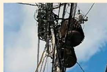
通りの無電柱化も2019年の完成を目指して工事中
