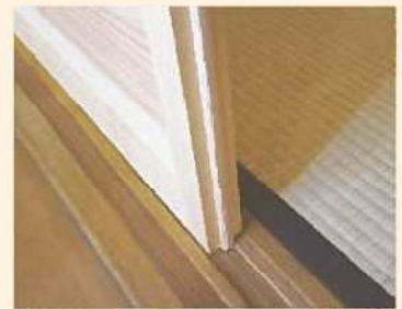
隙間を減らし、断熱性を 高めた木製建具
