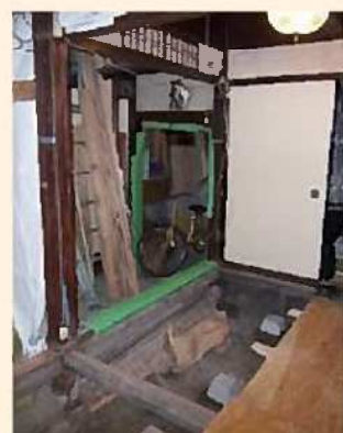
生活しながらの床暖房の工事の様子
