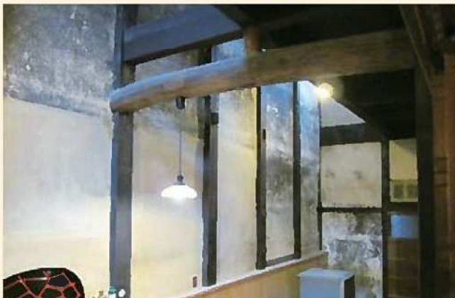
腕の良い左官の手仕事の跡を、あえて残している台所部分（ふくらみのある梁部分）
